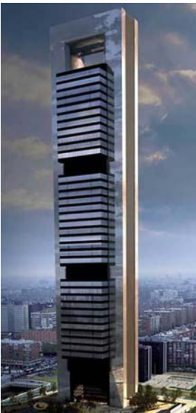
Torre Caja Madrid es el edificio más alto (250 m) de España
