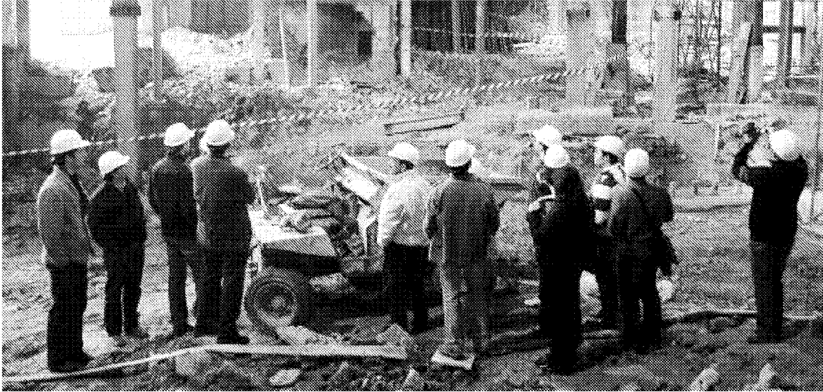
Visita a un edificio de Bilbao, en proceso de rehabilitación. / uc
