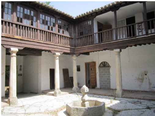
Perspectiva general del patio interior antiguo.
