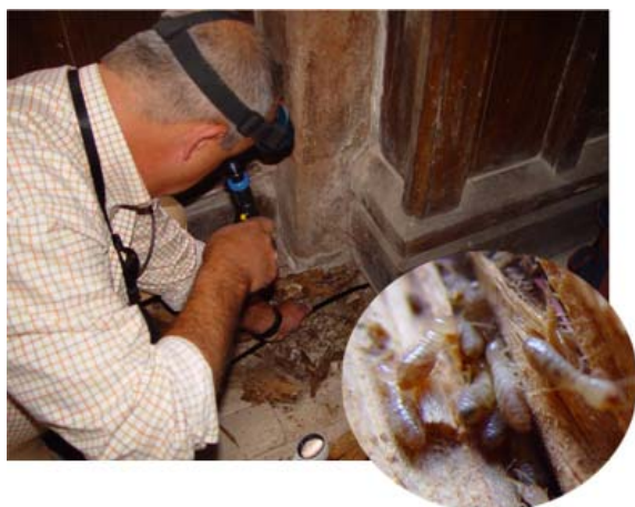
Inspección visual de signos producidos por organismos xilófagos mediante técnicas de visión artificial (endoscopio). Cortesía Montañesa de Desinfección.
