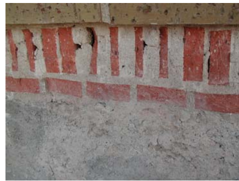
Figuras 5 y 6: Enchapado en forma de “L” cortado por los albañiles donde se ve claramente que apoya el ladrillo caravista, también cortado, sobre ellas.
