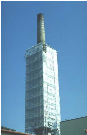
Figura 8: Andamiaje y protección
