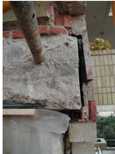
Figura 8: Parte baja de la foto anterior. Separación de las plaquetas del canto de forjado con desplazamiento vertical de la hoja superior.
