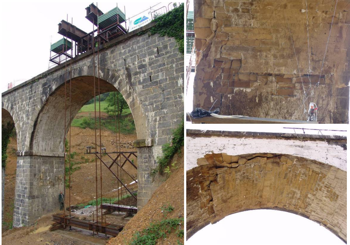
Figura 12: Vista general durante la prueba, y detalle del fallo a compresión en los sillares.
