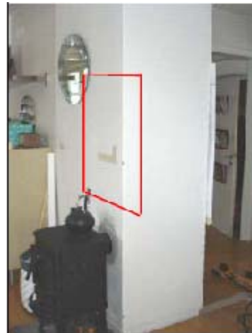
Figura 6: Fotografía de la chimenea objeto de estudio, lado norte y lado sur respectivamente.
