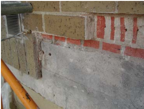
Figuras 5 y 6: Enchapado en forma de “L” cortado por los albañiles donde se ve claramente que apoya el ladrillo caravista, también cortado, sobre ellas.
