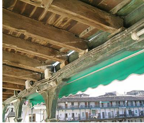
Figura 23: Cuñas y otros objetos calzando las viguetas.
