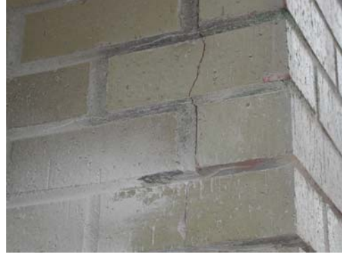
Figuras 3 y 4: Grietas en ladrillo cara vista reparándose en estos momentos por la empresa constructora.
