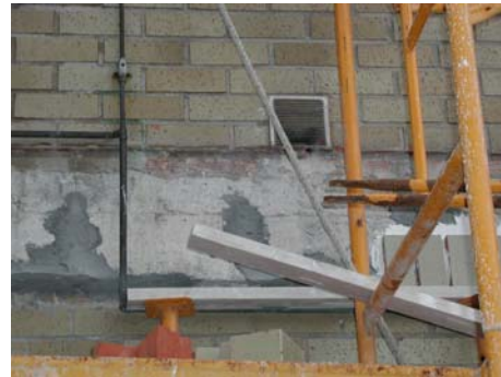
Figuras 12 y 13: Vistas de la primera hilada armada con ladrillo hueco doble.
