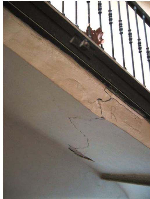
Agrietamientos asociados con las rótulas plásticas formadas en las escaleras por imposibilidad de contener en su espesor la línea de presiones. Rótula plástica en la zanca que sube al forjado de 2ª planta
