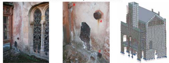
Situación de los tres tirantes detectados en el lado Este
