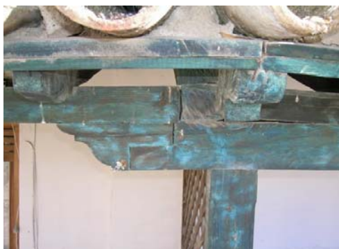
Figura 24: Empalme defectuoso en zapata.
