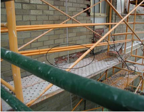
Figura 10: Apoyo sobre ladrillo hueco doble
