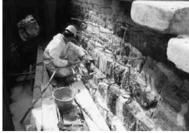
Figura 33: Elemento de costura capaz de soportar esfuerzos de tracción
