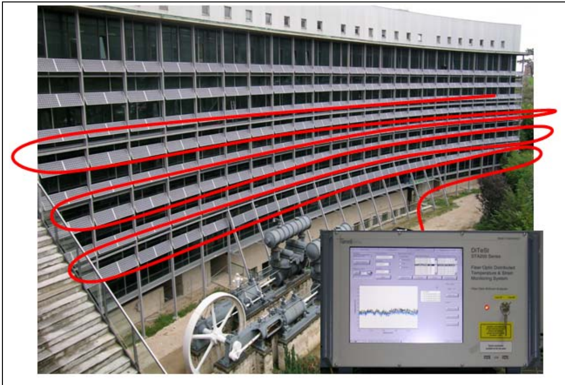
Figura 9: Ilustración de un sensor distribuido de fibra óptica situado sobre los paneles solares de la fachada sur de la Escuela Técnica Superior de Ingenieros Industriales y de Telecomunicación de la Universidad de Cantabria. En rojo la fibra sensora sobre la que se puede medir la elongación y/o la temperatura de forma distribuida al ser interrogada por la Unidad Optoelectrónica (UO). La UO de la fotografía, cuyo funcionamiento se basa en dispersión estimulada de Brillouin, es la que el Grupo de Ingeniería Fotónica dispone en la UC. http://gif.teisa.unican.es
