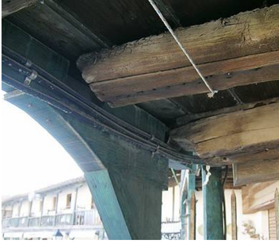
Figura 22: Falta de apoyo de los extremos de las ménsulas sobre la falsa jácena.
