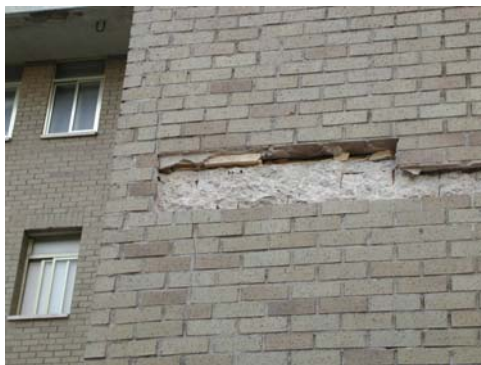
Figura 18: Ladrillo hueco sencillo reventado, hierros del canto de forjado asomando, grietas en fachada y forjado claramente picado con martillo.
