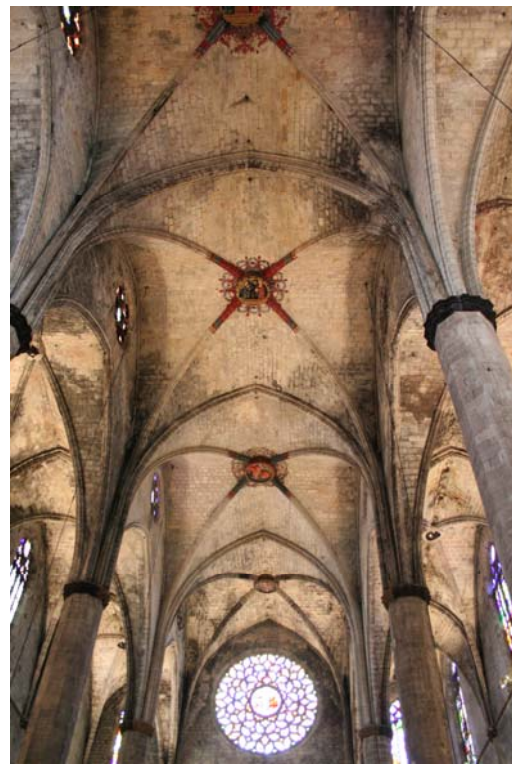
Figura 2: Vista general de las bóvedas
