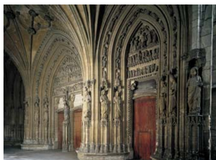
Foto 5: Estado de las portadas del pórtico antes de la intervención. (Quintas Fotografos)
