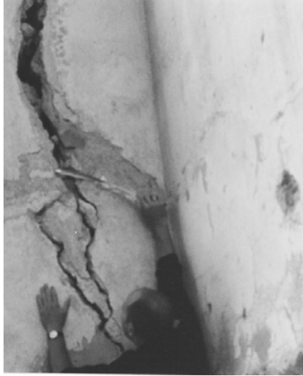
Figura 18: Muro fisurado por asentamiento diferencial del suelo.
