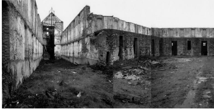
Figura 1 Fotografía del estado previo a la rehabilitación
