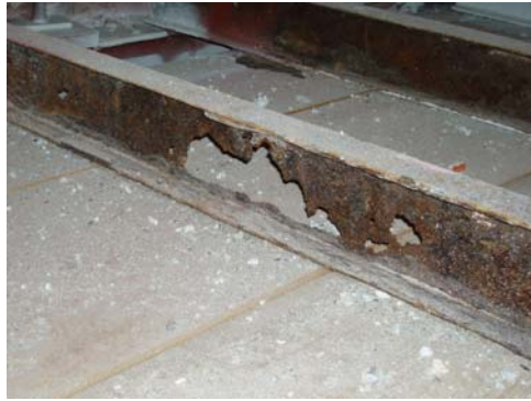
Figura 11: Pérdida total de sección
