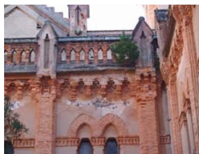
Figura 14: Falta de mantenimiento de cubiertas y terrazas causa daños sobre las fábricas.
