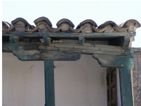
Figura 25: Empalme defectuoso en viga.
