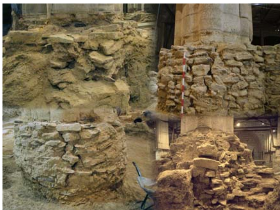
Figura 8: Estado de las cimentaciones de la nave principal (Fundación Catedral Santa María)
