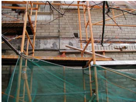
Figuras 12 y 13: Vistas de la primera hilada armada con ladrillo hueco doble.
