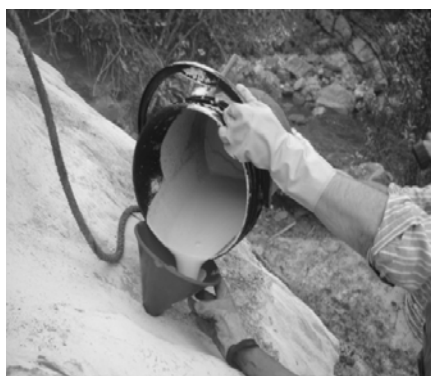
Figura 39: Inyección de mortero expansivo en roca.
