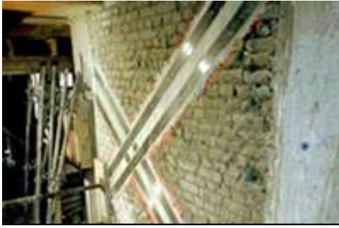
Figura 5: Refuerzo de muros
