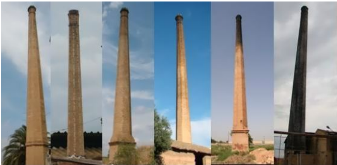
Figura 2: Chimeneas de Aldaia
