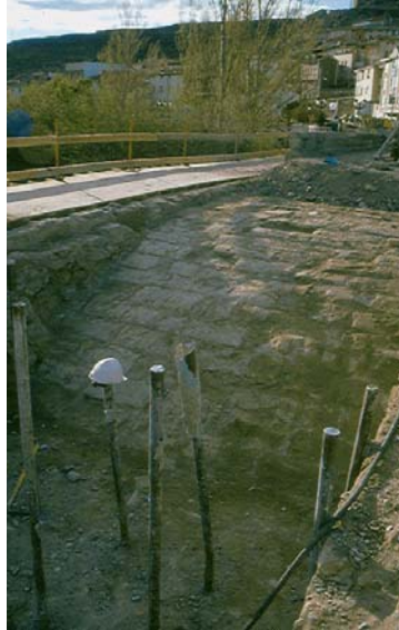
Figura. 3: Pte. de Cerezo de Río Tirón Vaciado de bóvedas
