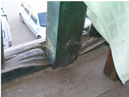
Figura 28: Aplastamiento por pudrición.
