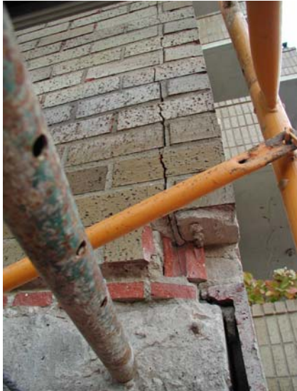
Figura 7: Fisura longitudinal en la fachada aparentemente por mal apoyo de la hoja ayudada por las dilataciones
