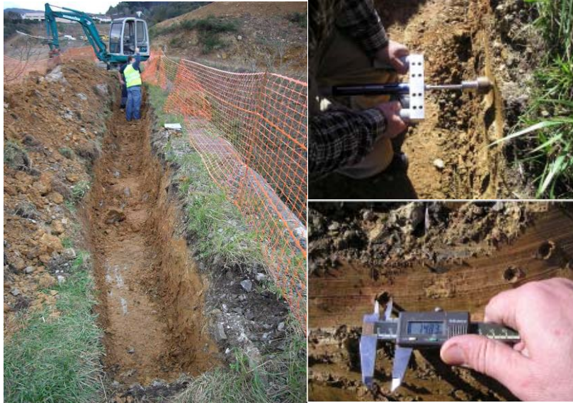
Figura 6: Remoción del relleno granular y desarrollo de pruebas geotécnicas.
