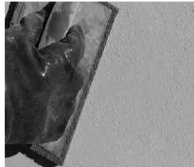
Figura 37: Paso 2 Acabado de mortero fino de cal hidráulica y arenas finas.
