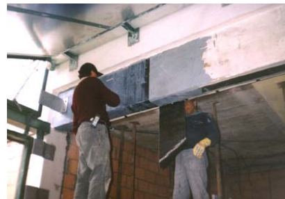
Figura 4: Refuerzo a cortante
