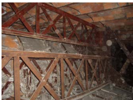
Figura 6: Detalle anillo de bóveda
