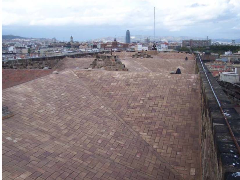
Figura 4: Sobre las bóvedas de la nave central
