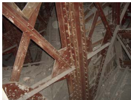
Figura 7: Celosía interior de bóveda
