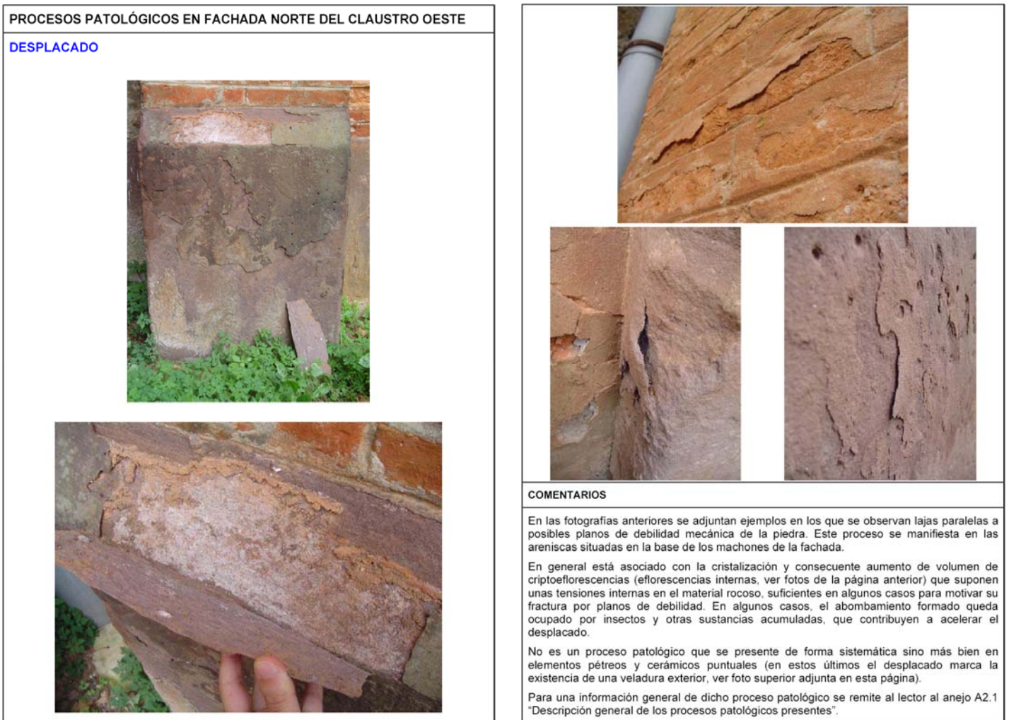
Figura 1: Ficha para el levantamiento de daños visibles.
