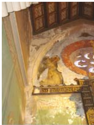
Figura 12: Lesiones producidas por el agua en la capilla.
