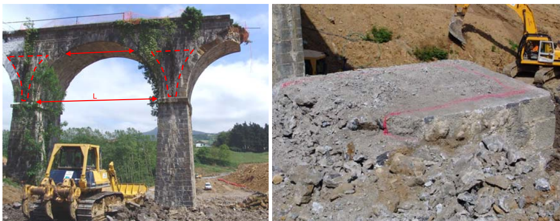
Figura 16: Alzado y sección de las pilas de la estructura
