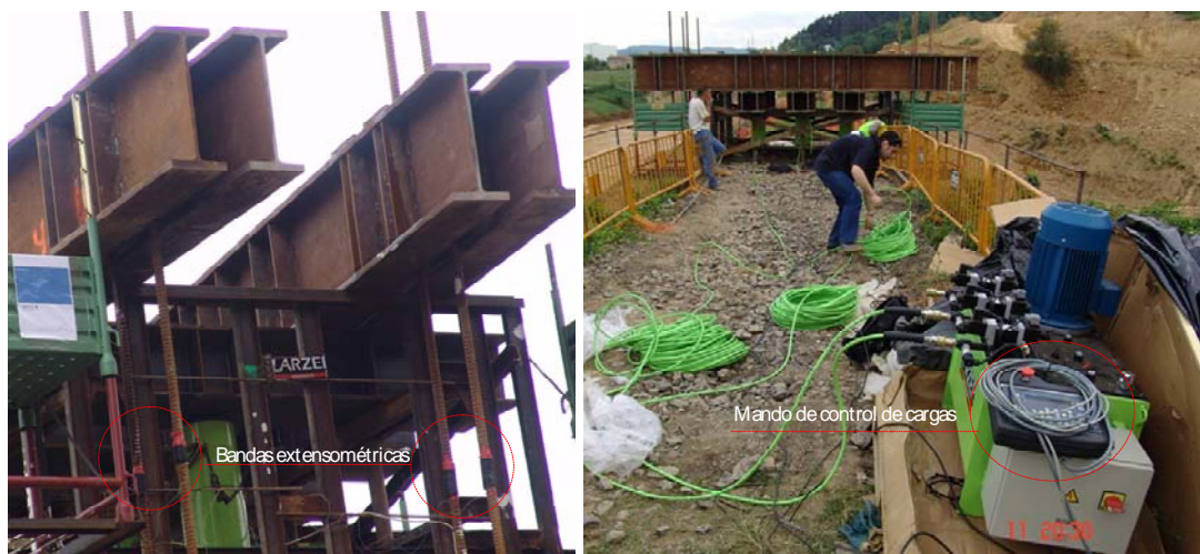
Figura 8: Izquierda, localización de las bandas extensométricas en los tirantes del lado monte. Derecha, detalle del mando de control de la bomba electro-hidráulica.
