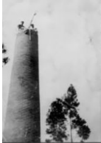
Figura 6: Ejemplo de cómo subía la construcción
