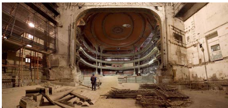
Figura 5: Vista desde escenario. Se aprecian los pilares ornamentados soporte de la bóveda y la estructura de camerinos en el hombro izquierdo
