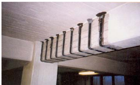
Figura 3: Refuerzo a cortante
