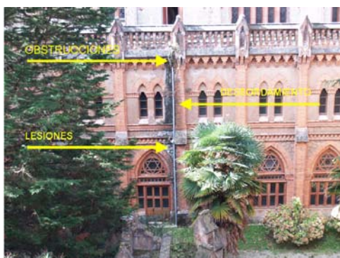
Figura 15: Obstrucción de la gárgola, desbordamiento de la bajante y lesiones en las fábricas.
