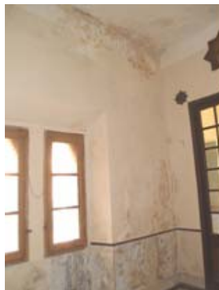
Figura 10: Puntos de infiltración del agua de lluvia.
