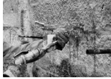
Figura 33: Elemento de costura capaz de soportar esfuerzos de tracción
