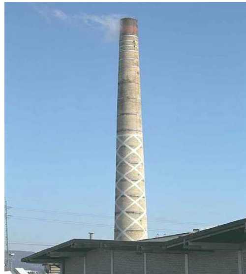
Figura 15: Chimenea de ladrillo reforzada con SikaWrap-230 C
