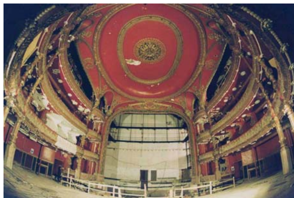
Figura 4: Vista general del interior del edificio en su estado previo comienzo de obra en 2006.
