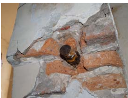
Figura 17: Tirante cortado en el interior
