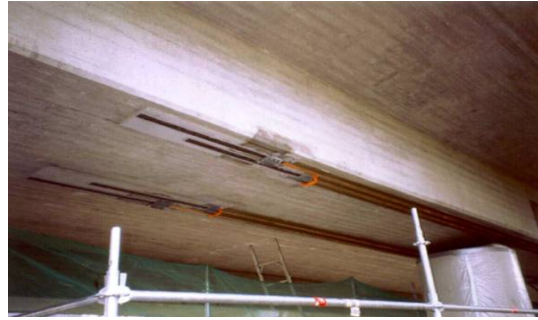
Figura 6: Refuerzo en pretensados
