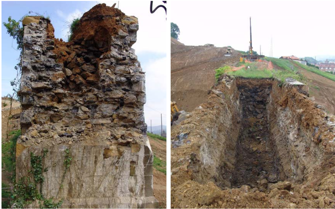
Figura 15: Típanos sobre la bóveda 3 y muros de acompañamiento del estribo 2.
