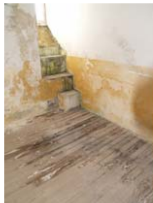
Figura 11: Puntos de infiltración del agua de lluvia.
