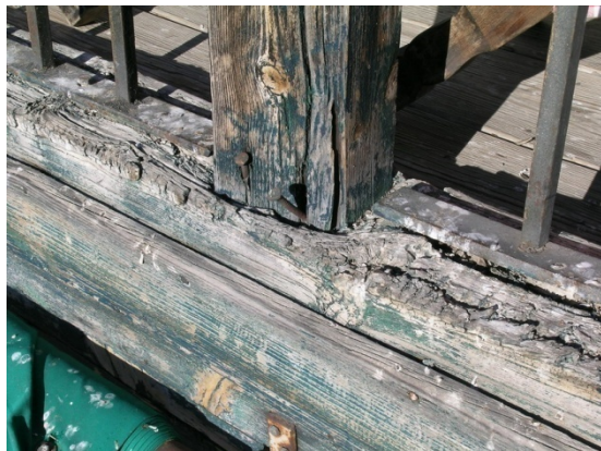
Figura 29: Aplastamiento por pudrición.
