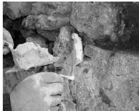
Figura 35: Paso 2 Aplicación de mortero especial con cal hidratada.
