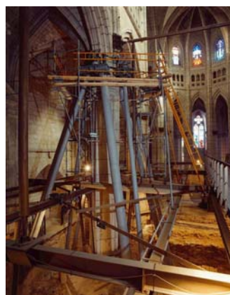
Figura 9: Apeo preventivo en un pilar (Quintas Fotógrafos)
