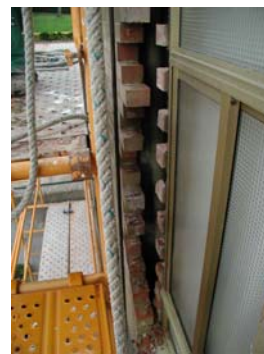
Figura 15: Pared desplazada vista desde otro ángulo
