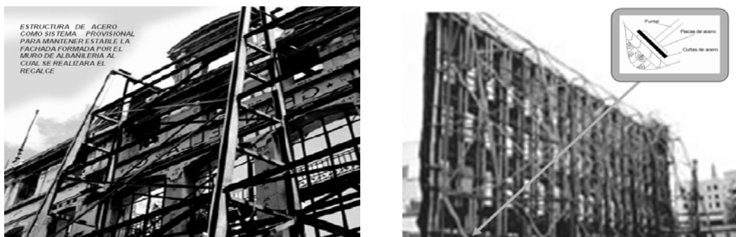
Figura 28: Refuerzo provisional y apuntalamiento
