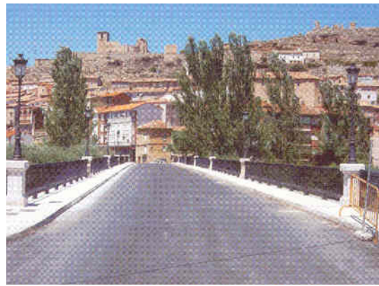
Figura 2: Pte. de Cerezo de Río Tirón Estado reformado
