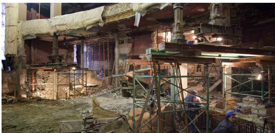
Figura 10: Pilares de fundición apeados
