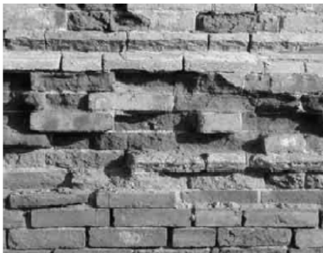
Figura 34: Paso 1 - Disgregación del ladrillo y parte de la junta del mortero
