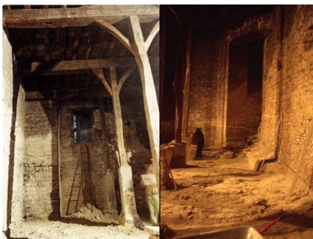
Foto 3: La sala de acceso antes de la reforma (LyC arquitectos)
