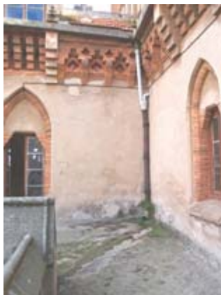
Figura 19: Deficiente diseño y ejecución de la actual red de recogida de pluviales.
