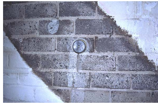
Figura 9: Preparación del soporte/Ensayo Sattec
