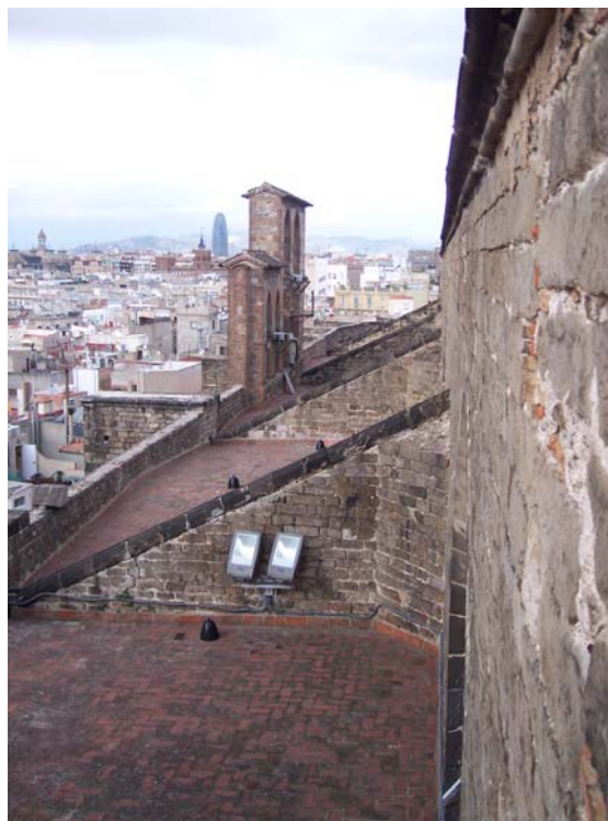
Figura 5. Aspecto de las cubiertas de la nave lateral del lado del evangelio.
