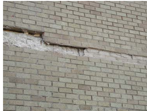
Figura 19: Hierros asomando en la misma zona que la foto anterior, se ve como buscaron conseguir mayor espesor picando el forjado para colocar con mortero el aplacado.
