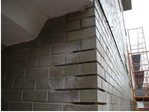
Figuras 3 y 4: Grietas en ladrillo cara vista reparándose en estos momentos por la empresa constructora.
