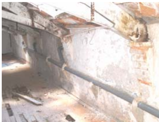
Figura 20: Deficiente diseño y ejecución de la actual red de recogida de pluviales.
