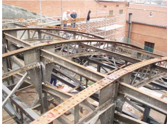
Figura 9. Estructura soporte cubierta original caja escénica
