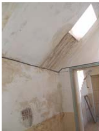
Figura 9: Puntos de infiltración del agua de lluvia.
