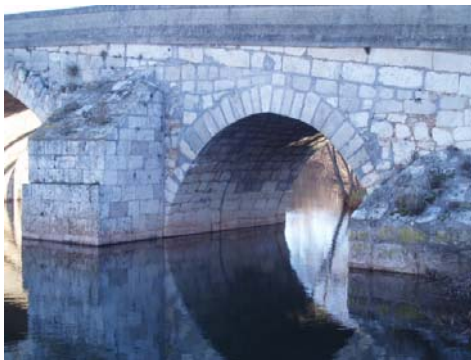
Fig. 4. Pte. de Puentedura (río Arlanza) Bóvedas paralelas
