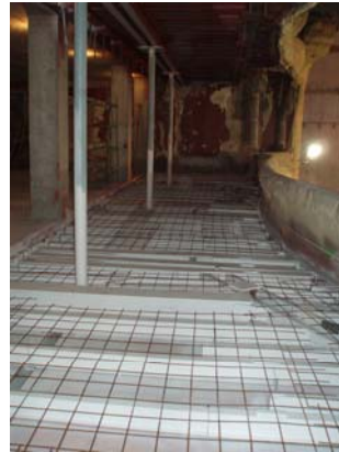
Figura 12: Forjado preparado para hormigonar
