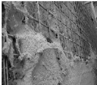
Figura 36: Paso 1 - Mortero de cal hidratada y malla de refuerzo
