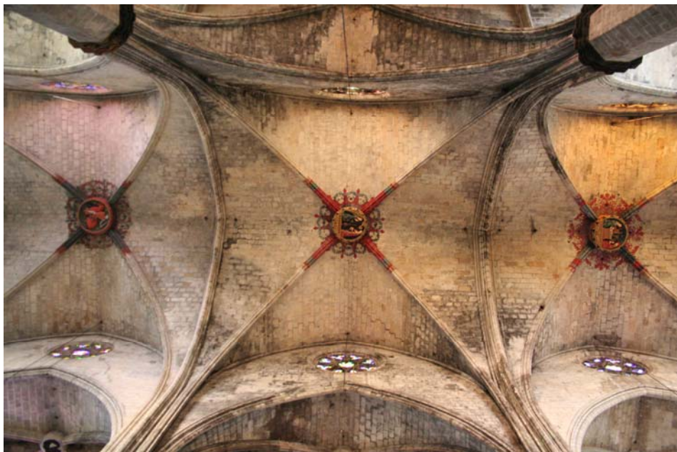
Figura 3: Vista de las bóvedas de crujiás de la nave central
