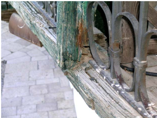
Figura 26: Desencaje por pudrición.
