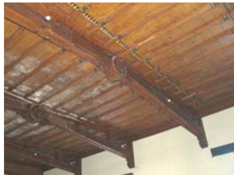
Figura 25: La zona interior, igualmente, requiere una intervención inmediata.
