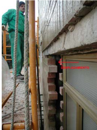
Figura 16: Desplazamiento en horizontal peligroso
