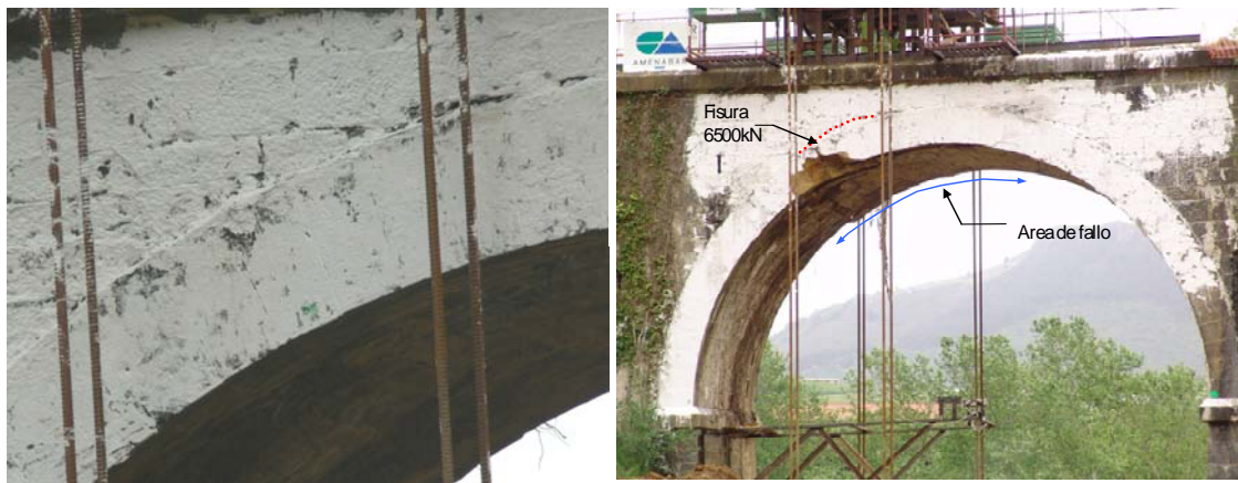
Figura 11: Izquierda, vista de la bóveda cargada con 6500 kN, evidencia de formación de fisura de separación entre tímpano y bóveda. Derecha, vista de la bóveda después del colapso (7466,64 kN). Se traza sobre ella el lugar de aparición y la extensión de la fisura de separación entre tímpano y boquilla, así como el área dañada resultante después del colapso.
