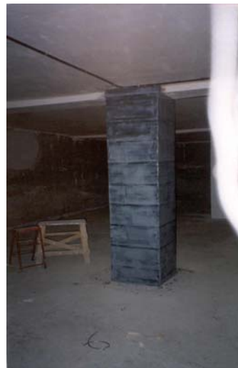
Figura 2: Refuerzo por confinamiento
