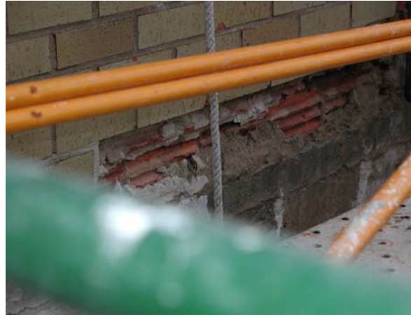
Figura 11: Ampliación de la foto anterior donde se ve el canto del forjado y el ladrillo hueco doble armado a tabicón.
