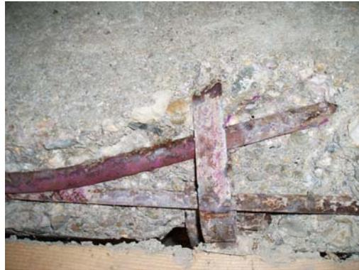
**Figuras 26, 27 y 28:** Fotografías y croquis del armado de una viga de la estructura del edificio de la Alhóndiga.
