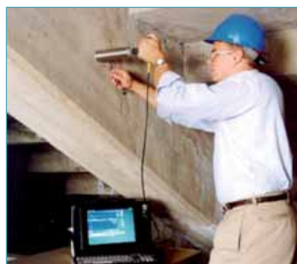
Figura 7 - Equipamiento de un ensayo de impacto-eco. [8]
