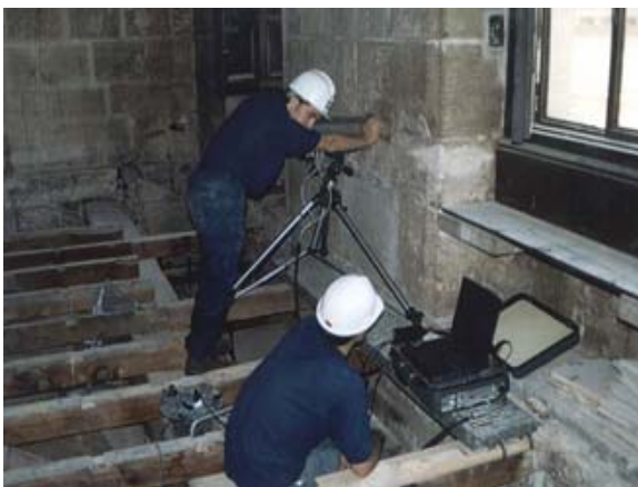
Figura 13: Imagen del proceso del taladrado con el equipo DMRS. (Fuente: Aidico)
