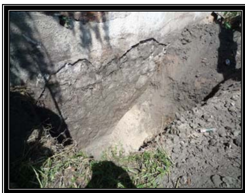
Fig. 25: Cimentación de estribos
