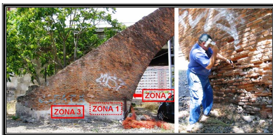
Fig. 3 y 4: Zonas de toma de muestras (la zona 1 corresponde con la cara opuesta a la mostrada en la fotografía) y detalle de un instante de las tareas de extracción.
