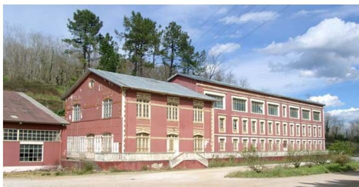
Figura 1 - En el estudio previo a la rehabilitación de este edificio de oficinas hubo que reconocer y caracterizar sus diferentes elementos estructurales que eran desconocidos.
