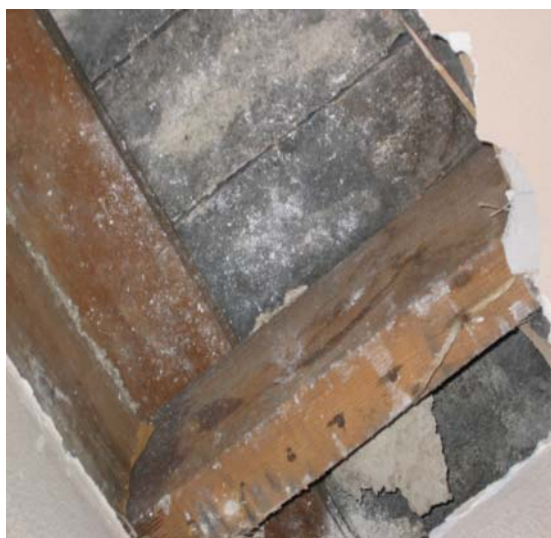
Figura 7 - Cata realizada en un forjado de un edificio que iba a rehabilitarse: Se observa una losa de viguetas de hormigón, adosadas una junto a otra, sobre un forjado existente de viguería de madera.
