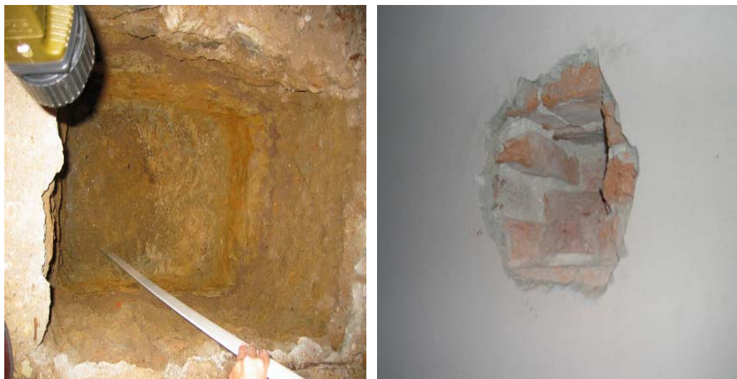
Figuras 8 - A la izquierda se recoge un pozo realizado junto a un muro de carga (para conocer el tipo de terreno de cimentación y la profundidad del NF). A la derecha se muestra un aspecto de la constitución del citado muro (una fábrica de ladrillo macizo).
