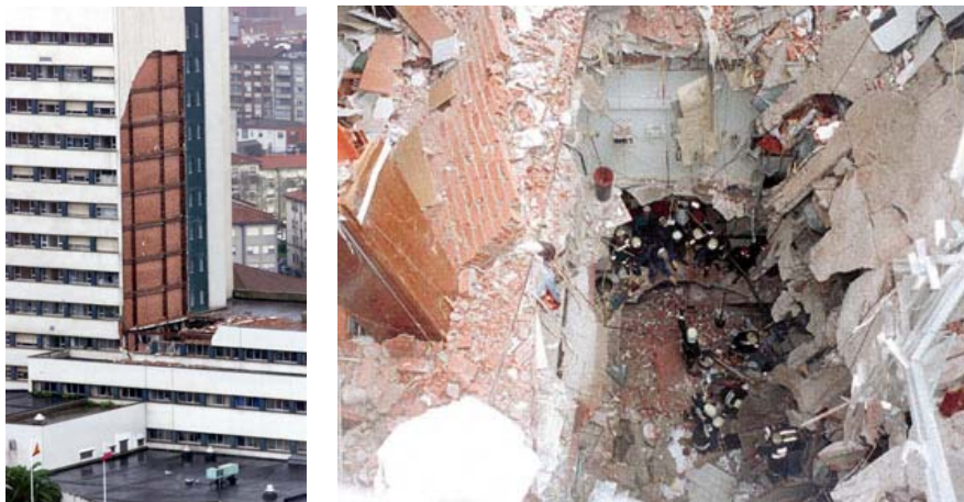
Fig. 7: Derrumbe de la fachada de un hospital y colapso de los forjados sobre los que cayeron los escombros.
