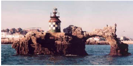
Figura (1): La “Horadada” previamente al colapso
