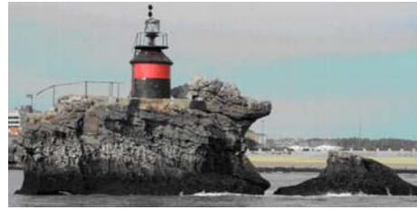
Figura (2): La “Horadada” con posterioridad al colapso
