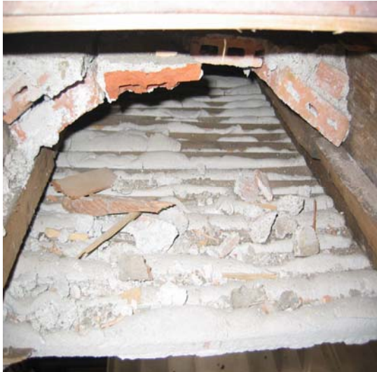
Figura 6: Cata realizada en un forjado de un edificio a rehabilitar y en donde pueden verse los diferentes elementos del mismo: Viguetas de madera, bovedillas de ladrillo, tarima y falso techo.
