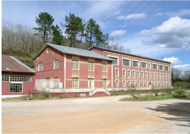
Figura 1: En el estudio previo a la rehabilitación de este edificio de oficinas hubo que reconocer y caracterizar sus diferentes elementos estructurales que eran desconocidos.
