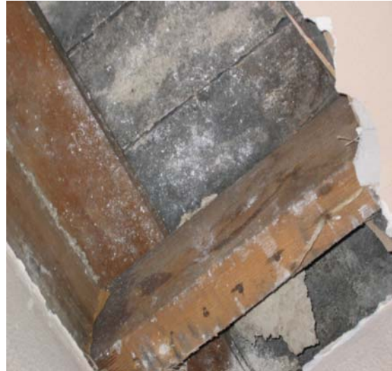
Figura 7: Cata realizada en un forjado de un edificio que iba a rehabilitarse: Se observa una losa de viguetas de hormigón, adosadas una junto a otra, sobre un forjado existente de vigería de madera.
