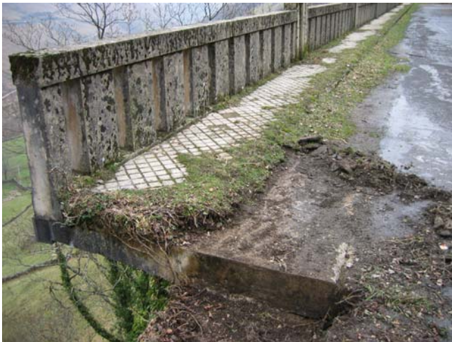
Fotografías 12: Voladizo existente (izquierda) sobre una arcada de bóvedas de hormigón (derecha): La estabilidad a vuelco de aquél no era adecuada y una parte del mismo ha colapsado (se aprecia en ambas imágenes) por falta de equilibrio estático.
