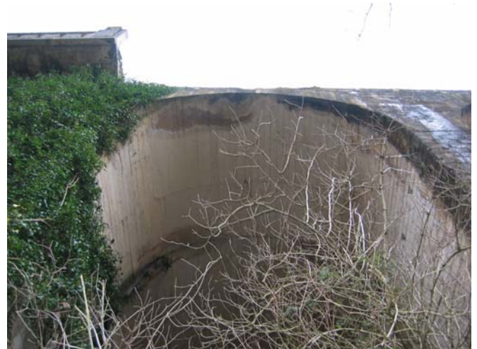
Fotografías 12: Voladizo existente (izquierda) sobre una arcada de bóvedas de hormigón (derecha): La estabilidad a vuelco de aquél no era adecuada y una parte del mismo ha colapsado (se aprecia en ambas imágenes) por falta de equilibrio estático.
