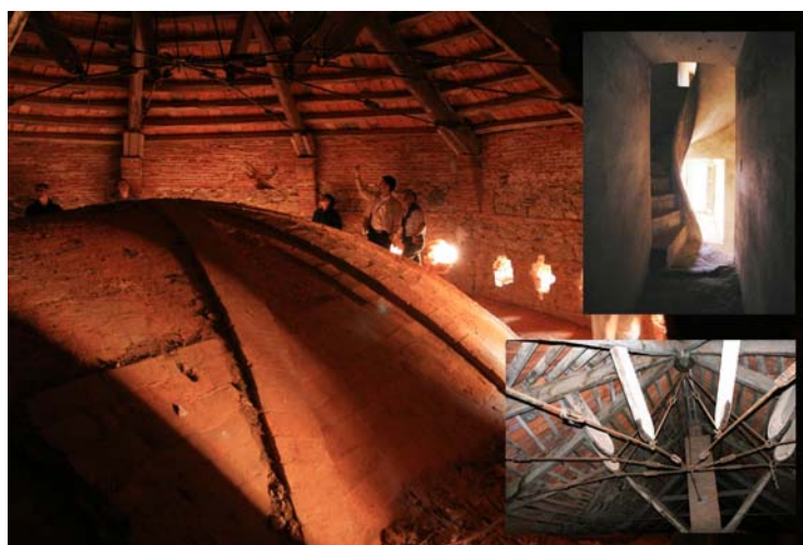
Trasdós del abovedado, detalle de la escalera de caracol y del nudo tridimensional de la cubierta en la zona del ábside
