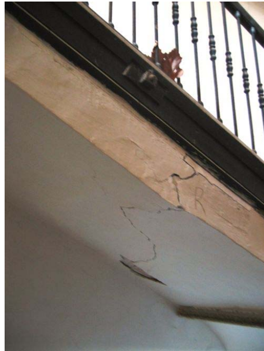
Agrietamientos asociados con las rótulas plásticas formadas en las escaleras por imposibilidad de contener en su espesor la línea de presiones. Rótula plástica en la zanca que sube al forjado de 2ª planta
