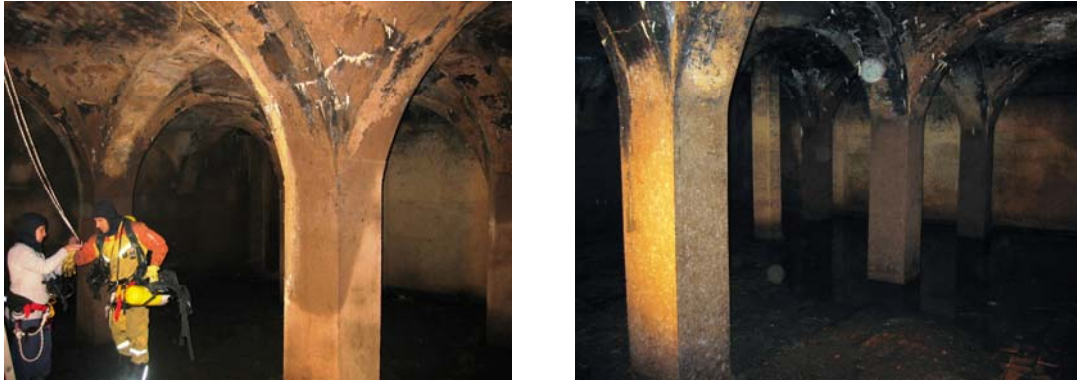
Detalles de la inspección realizada en el aljibe existente en el claustro Este
