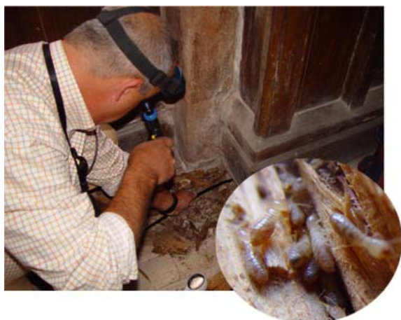
Inspección visual de signos producidos por organismos xilófagos mediante técnicas de visión artificial (endoscopio). Cortesía Montañesa de Desinfección.
