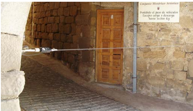
Figura 26: Cinta de convergencia en proceso de lectura. Cortesía: LABEIN.
