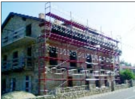
Rehabilitación de un albergue en Ruiloba.
