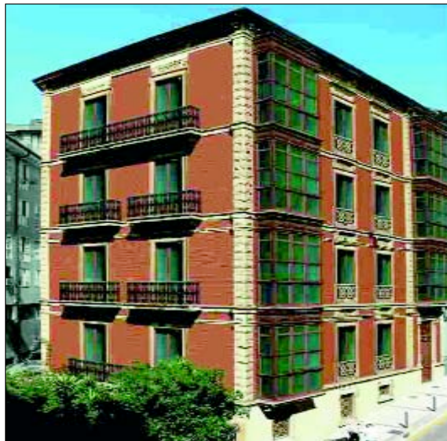
Edificio de la Plaza de Cañadío adquirido por Triguero para su rehabilitación.
