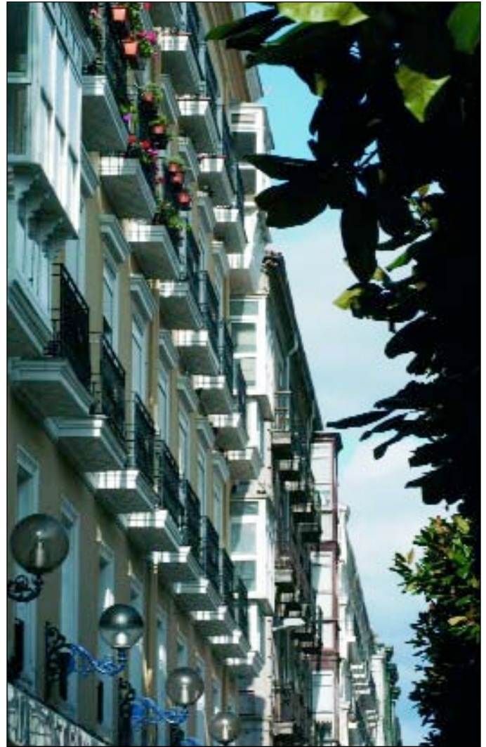
El peso de la rehabilitación y el mantenimiento de la edificación es tan importante como la obra civil. FOTO: ROMAN ALONSO
