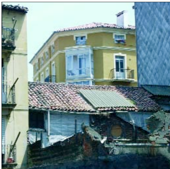
La fisonomía de los centros urbanos debe cambiar con la demolición de tapias y casas tapón como la de la fotografía.
