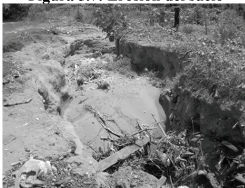
Figura 5.7: Erosión del suelo
