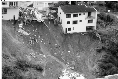
Figura 5.14: Deslizamiento de laderas
