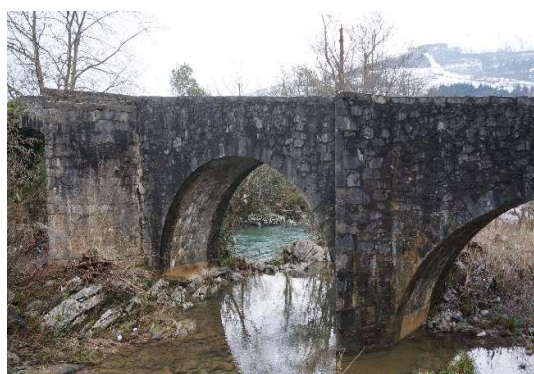
Fotografías 15 y 16 (LV): Dos aspectos del bello “Puente Viejo de Ramales de la Victoria” (siglo XVII): A la izda. se muestra su alzado aguas arriba, donde destacan sus tajamares de sección triangular, y a la dcha. sus pretiles y el pavimento encachado.
