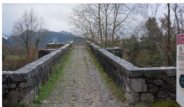
Fotografías 15 y 16 (LV): Dos aspectos del bello “Puente Viejo de Ramales de la Victoria” (siglo XVII): A la izda. se muestra su alzado aguas arriba, donde destacan sus tajamares de sección triangular, y a la dcha. sus pretiles y el pavimento encachado.
