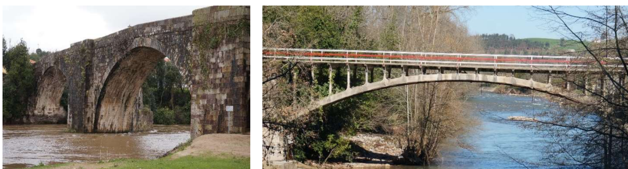
Fotografías 1 y 2 (LV): Dos puentes BIC de Cantabria (de los tres inventariados en este nivel de protección): El puente de Arce sobre el río Pas (de bóvedas pétreas del siglo XVI) y el de puente de Golbaro sobre el río Saja (de arcos de hormigón armado de 1902).
