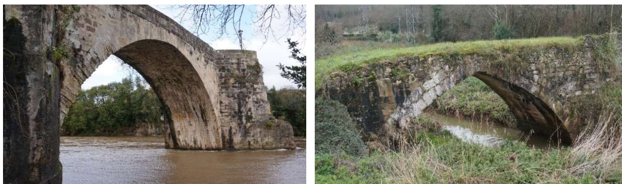
Fotografías 7 y 8 (LV): Dos puentes inventariados del siglo XVI en Cantabria: El de Arce en el municipio de Piélagos (izq.) es BIC y el arco rehabilitado del antiguo puente de Solía en el ayuntamiento de Villaescusa (dcha.) es BIN.
