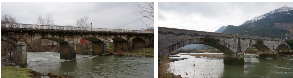
Fotografías 29 y 30 (LV): Dos puentes del siglo XIX en Cantabria sobre el río Asón: El de Ampuero-Marrón (izd.) y el de Limpias (dcha.).
